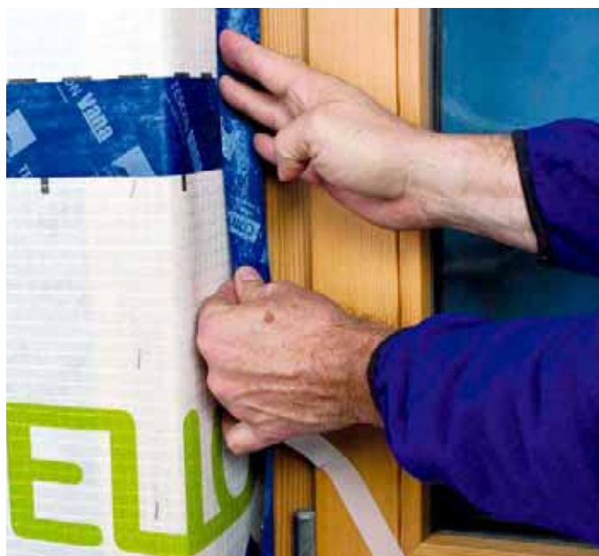
Die Lücke zwischen Fenster und Wand muss sorgfältig und sicher luftdicht abgedichtet werden, sonst drohen Feuchtigkeitsschäden und Wärmeverlust.
