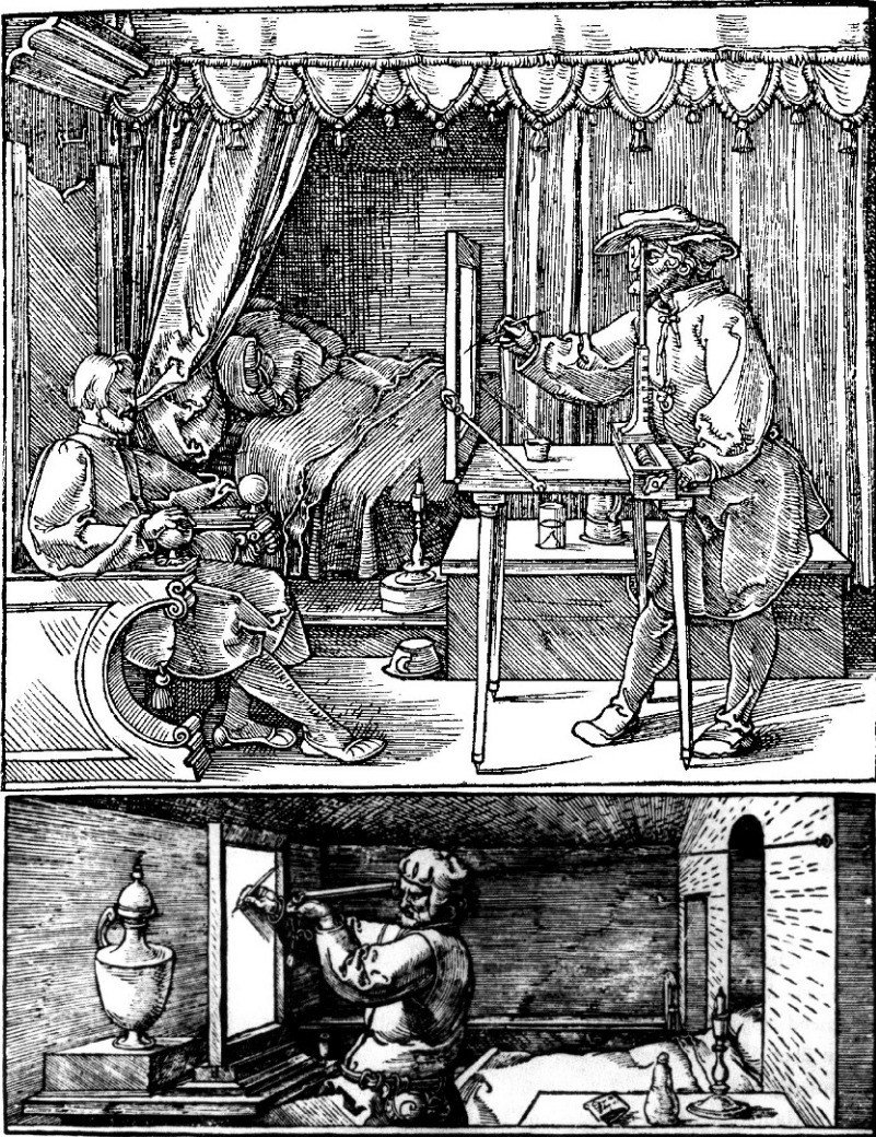
Abb. 5.3.2 Vorschläge Dürers zur mechanischen Erleichterung der Erzeugung perspektivischer Bilder: a) Das wesentliche Element ist hier der verstellbare Stab zur Fixierung des Augpunktes [Underweysung, 1525]. b) Indem der Zeichenstift mit einem in die rückwärtige Wand geschlagenen Nagel durch einen straffen Faden verbunden wird, kann der Augpunkt in eine Entfernung von der Bildebene gelegt werden, die größer als die Reichweite des Zeichners ist [2. Auflage der Underweysung 1538].
