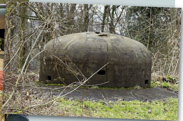
„GEKNACKT“: Durch eine Hohlladung 50 kg außer Gefecht gesetzte Artilleriebeobachtungsglocke des Forts Eben-Emael im gegenwärtigen Zustand. Foto: Archiv Schmachtenberg
