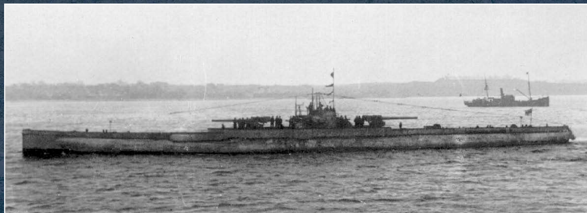
BEWAFFNET: Das mit zwei 15-cm-Geschützen ausgerüstete ehemalige Transport-U-Boot „Deutschland“ als Kriegsschiff nach seinem Umbau.
