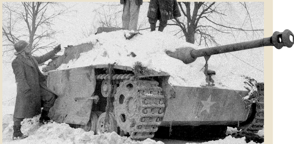
UNTER FALSCHER „FLAGGE“: US-Soldaten untersuchen eines der fünf Sturmgeschütze der Pz.Brig. 150, die für die Ardennenoffensive umgebaut wurden. Neben Blechplatten, die das Äußere verschleiern sollen, ist das Fahrzeug in Oliv gestrichen und mit amerikanischen Kennungen versehen worden.
