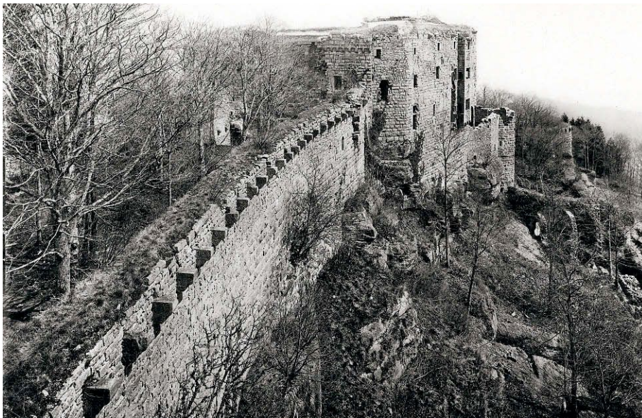
VORHER: Aufnahme des Zustandes der Burg vor Beginn des Wiederaufbaus und der Restaurierungsarbeiten.
