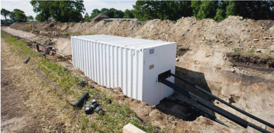
Abb. 8.45 Beispiel einer Einrichtung (Container) für die Erstellung einer Muffenverbindung für ein XLPE-HGÜ-Kabelsystem [33]
