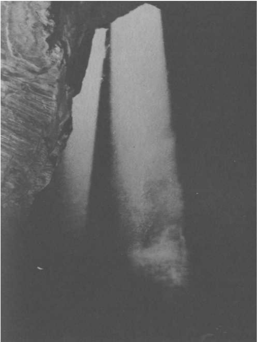
21 Alle 1100 m trifft man auf solche künstlich angelegten Ventilationsschächte, sie sind im Schnitt 1,80 bis 3,10 m lang und 80 cm breit.
