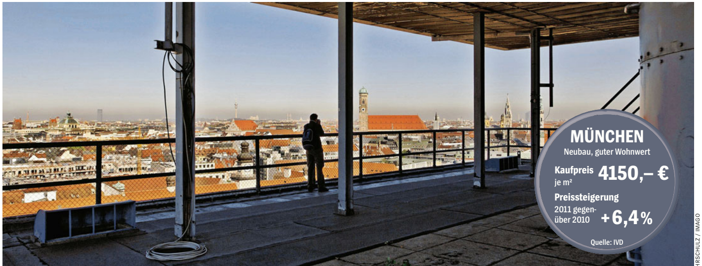
Blick vom Rohbau des Münchner Luxusobjekts „The Seven“: Ein Penthouse für angeblich mehr als 14 Millionen Euro
