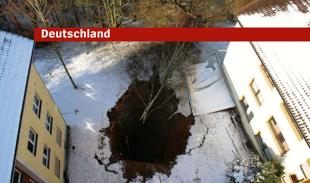
Durch Bergschäden verursachter Krater in Siegen
