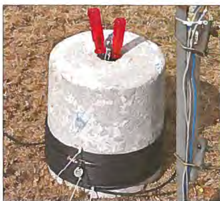
Improvisierte HF-Drossel mittels eines herumliegenden Betonssockels
