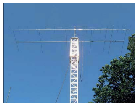
DG0UHF arbeitet auf 2 m mit 100 W an einer 18-Element-M 2 , 17 m hoch am Mast. 4 m darunter befindet sich eine 7-Element-M 2 für 50 MHz.
