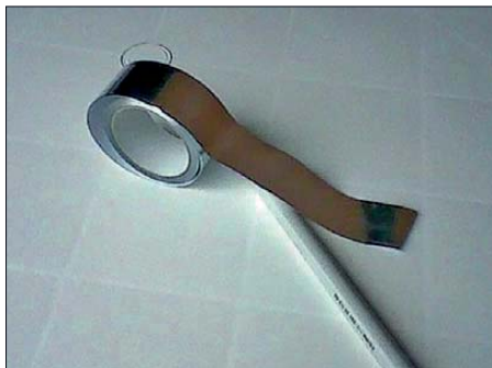
Bild 1: Das Weichaluminium ist spiralförmig und überlappend auf das Kunststoffrohr zu wickeln.
