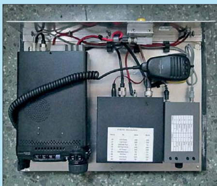
Bild 1: Montage mit installierten Geräten und rückseitiger Anschlussplatte
