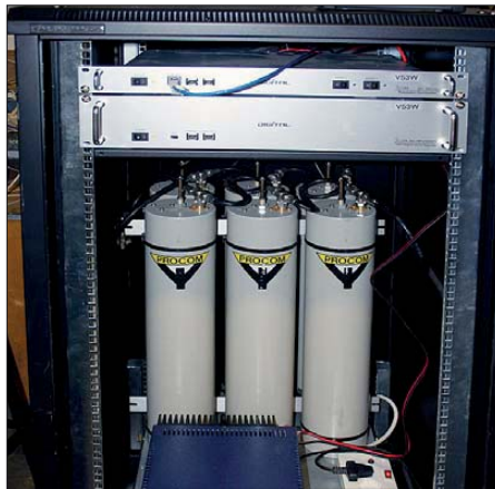
D-STAR: 2-m-Relais V53W_C in Windhoek (Namibia) mit Weiche Foto: V51JP
