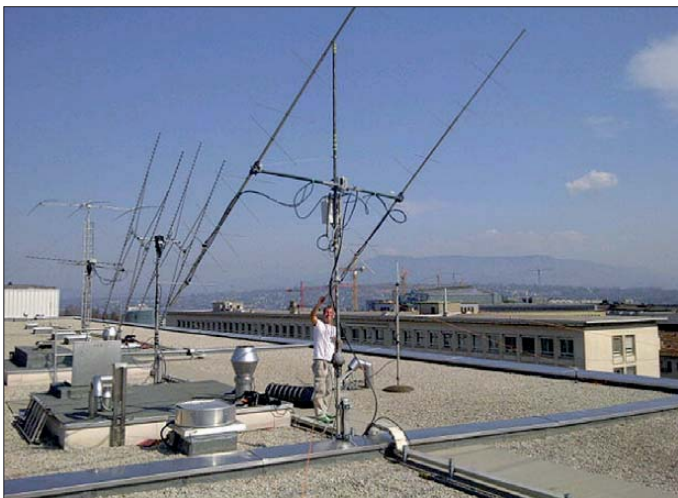
Jürgen, PE1LWT, auf dem Dach des ITU-Gebäudes in Genf. Vom 23. bis 25. 3. 12 führten PA2CHR, PA3FPQ, PE1L und er eine kombinierte EME/Meteorscatter/Tropo-DXpedition von 4U1ITU durch. Trotz erheblicher Störungen durch die Elektronik in den umliegenden Gebäuden reichte es für mehr als 120 EME-QSOs sowie einige schöne Tropo-Verbindungen bis nach Norddeutschland.
