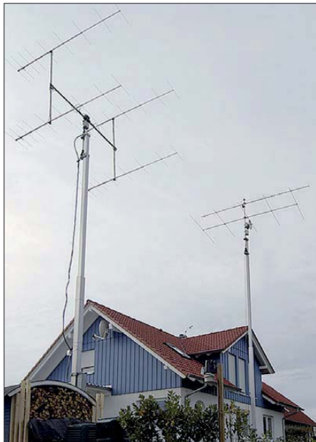
Die 4 × 9-Element-Gruppe von Udo, DK5YA. Im Hintergrund eine 5-Element-I0JXX für 50 MHz und eine 25-Element-I0JXX für 70 cm Foto: DK5YA
