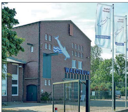
Bild 2: Gebäude der ehemaligen Sendefunkstelle Osterloog
