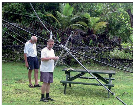
Sid, DM2AYO, und Klaus, DK1AX, beim Montieren des Spiderbeams (v. l.)
