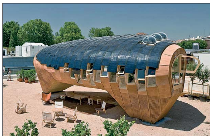
Bild 3: Das FabLab House aus digital erzeugten Einzelteilen
