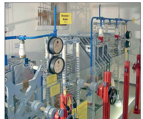
Bild 4: Abstimmereinheit der MW-Sendeantenne für 474 kHz und 500 kHz
