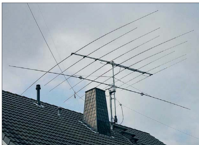
Bild 1: Der 40MDY-1 unterhalb eines Optibeam OB9-5 in endgültiger Aufbauhöhe von 12 m
