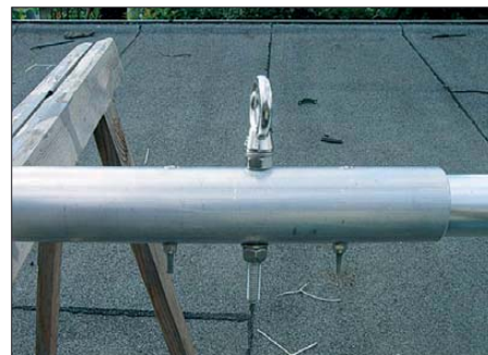
Bild 8: Um ein Durchhängen des Dipols zu verhindern, sind in diese Ösen die Abspannseile einzuhängen.
