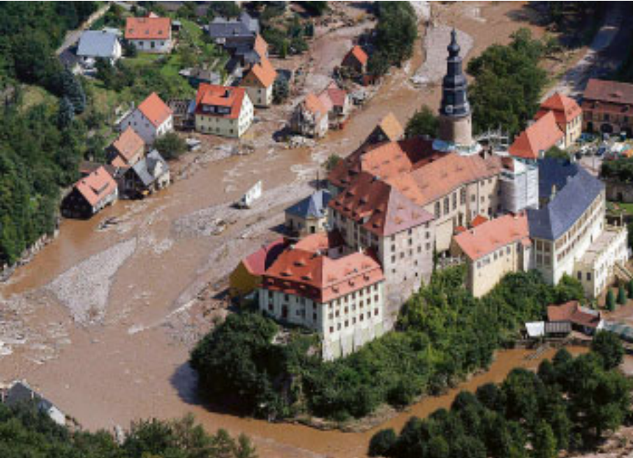
Weesenstein am 15. August 2002: Die zerstörerische Flut umspült das Schloss. Foto dapid
