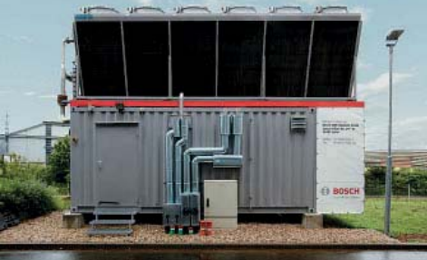
Kompakt: Wärmetauscher, Turbine und Speisepumpe bilden eine Einheit
