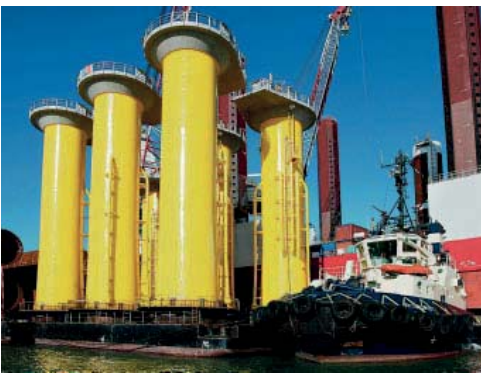
Größter Windpark der Welt: Fundamente für das „London Array“
