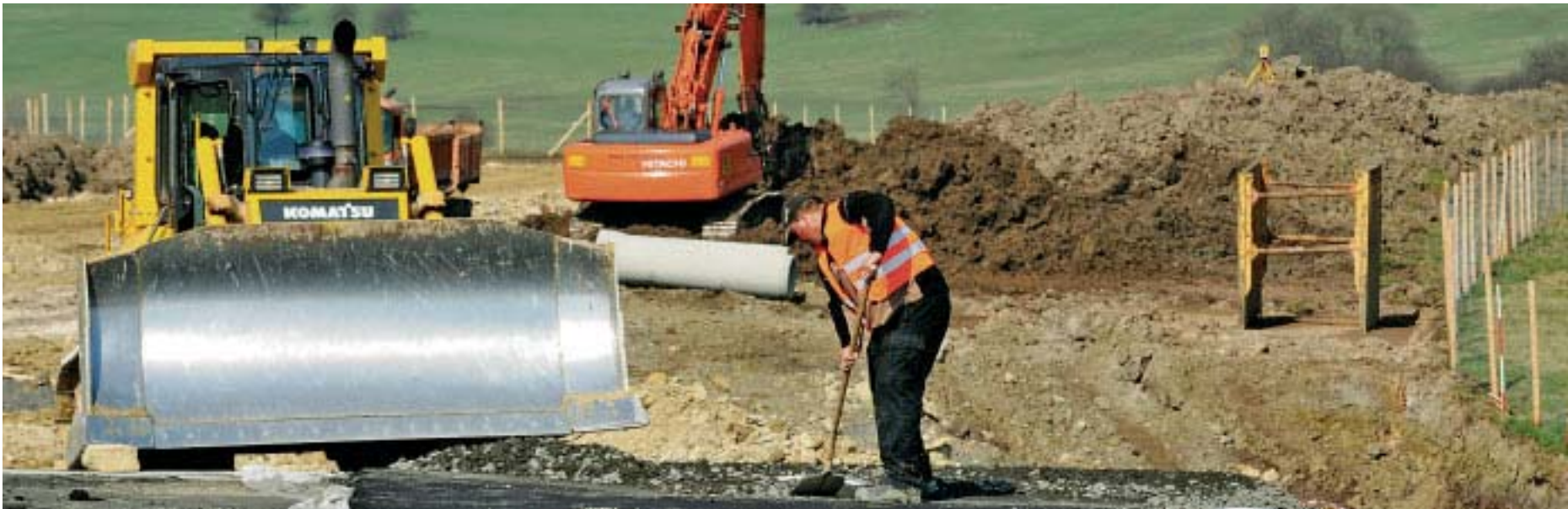
Auf der Baustelle: Das öffentliche Auftragsvolumen könnte in den nächsten zehn Jahren jährlich um 1 Prozent zurückgehen.
