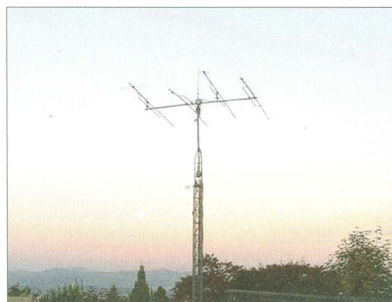
Antennen der ARISS-Ground-Station von HB9TSO Quelle: www.ariss.ch
