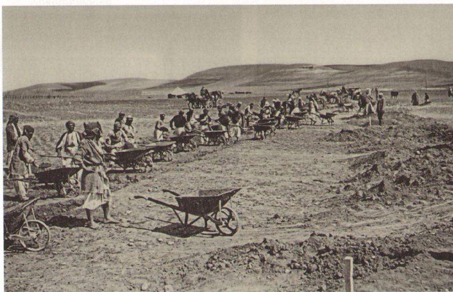
Bautrup der Bagdadbahn nahe Karkemisch: Mit Schaufeln und Schubkarren schütten die Männer Hunderte Kilometer Bahndämme auf
