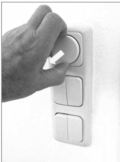
Abb. 43: Wenn Lichtschalter zusammen mit einem Lichtdimmer in einem gemeinsamen Rahmen untergebracht sind, muss vor der Demontage der Lichtschalter erst der Drehknopf des Dimmers abgenommen werden.
