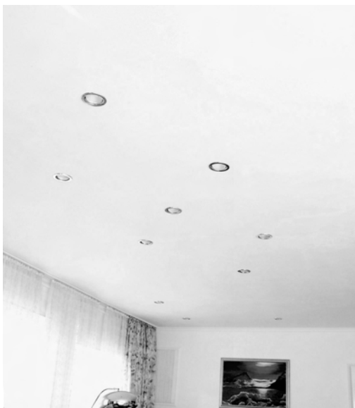
Abb. 22: Ausführungsbeispiel einer Wohnzimmerdecke mit Einbau-Deckenleuchten
