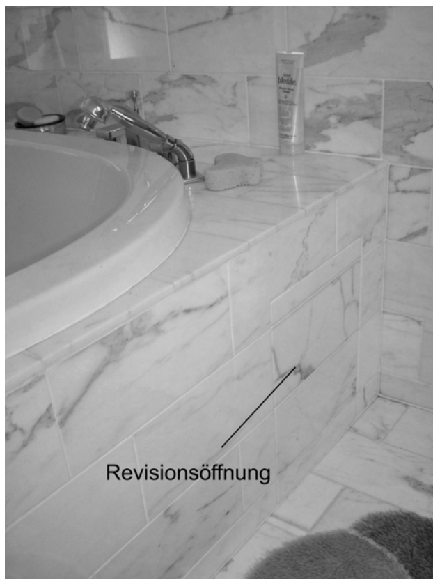
Abb. 104: Festgehalten wird diese Revisionsabdeckung von einem Möbel-Magneten.
