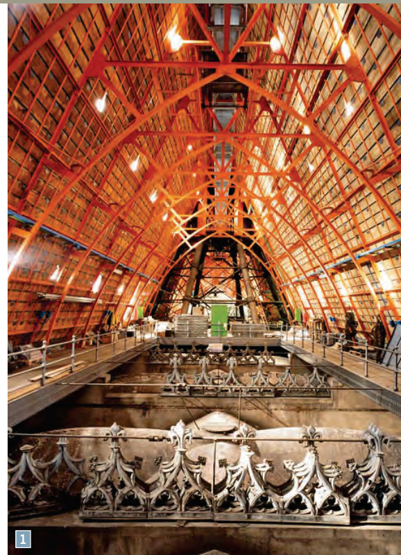
DACHSTUHL Über dem Chor kann man die aufwendig abgestützte Dachkonstruktion erkennen
