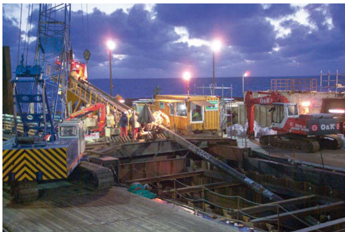
Bohrarbeiten in der Abenddämmerung. Aus der Baugrube heraus wird mittels horizontaler Richtbohrtechnik gebohrt. Dieses Verfahren minimiert im seeseitigen Bereich den Eingriff in den Wattboden während der Bauphase. © RWE Dea AG
