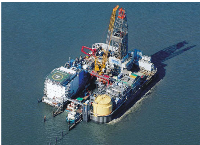
Die Bohr- und Förderinsel Mittelplate: Ein kompaktes System mit getrennten Wohn-, Bohr- und Prozessbereichen. © RWE Dea AG
