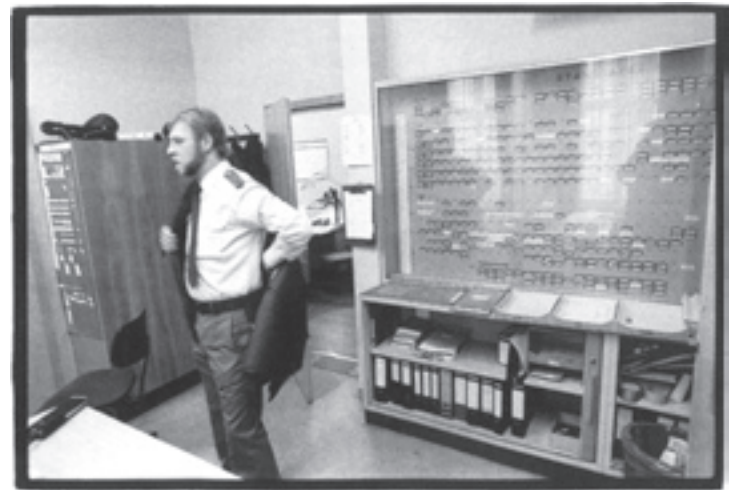
Alarmkontrollsystem in der Verwaltung
