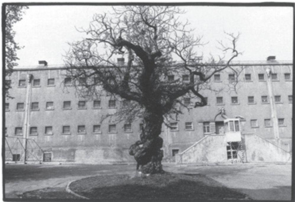
Blick vom Arbeitsbau auf den SZB
