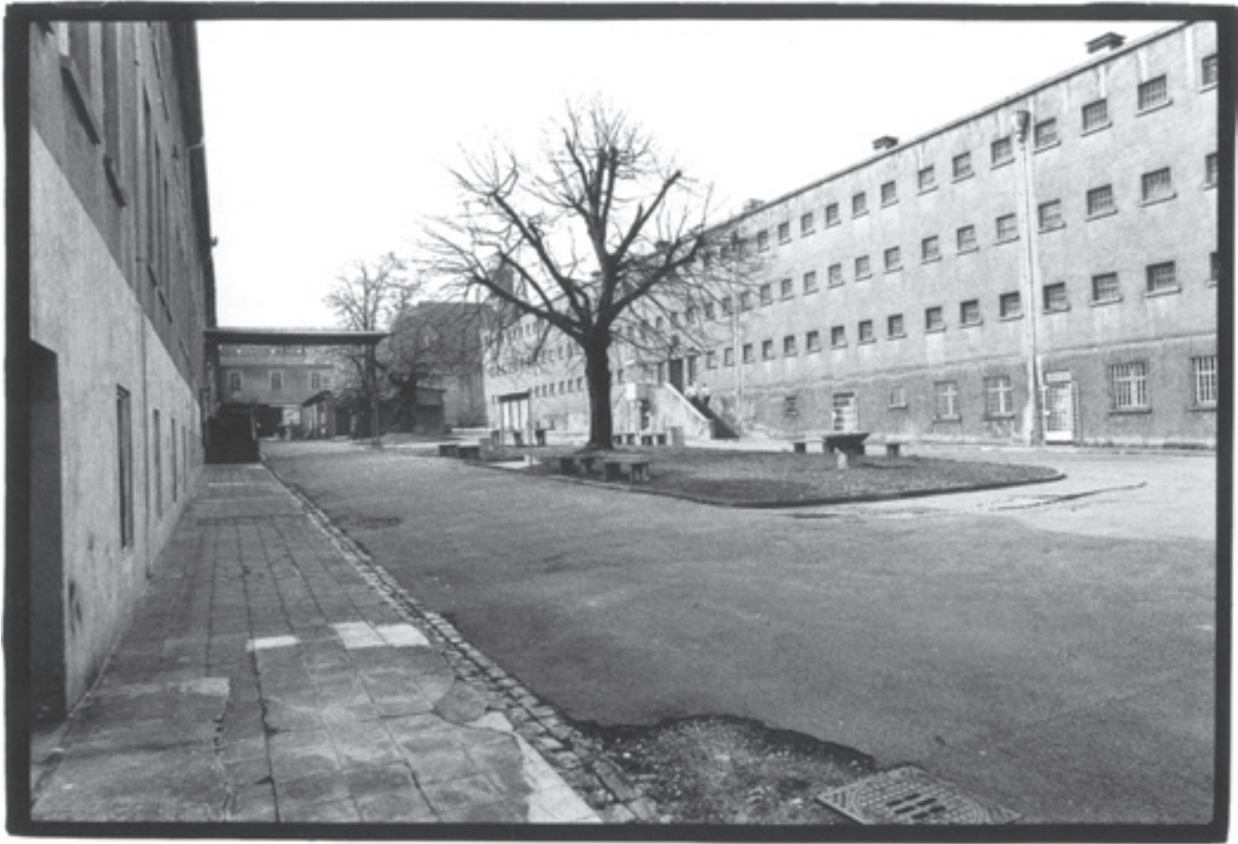
Hof zwischen SZB und Arbeitsbau
