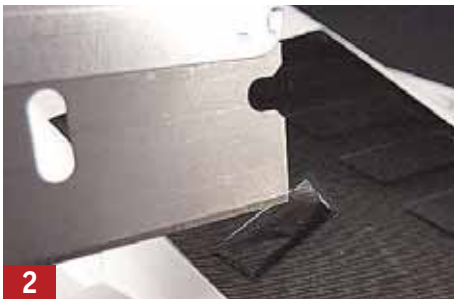
Hier muss zusätzlich Material an den Öffnungen vorsichtig eingeschnitten werden.
