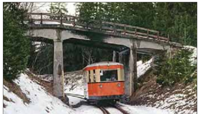
Bei Sorge an der Harzquerbahn fand man eine kleine Straßenbrücke aus Stahlbeton der Epoche II. Foto: Christoph Weinkopff/Slg. S. Koch.
