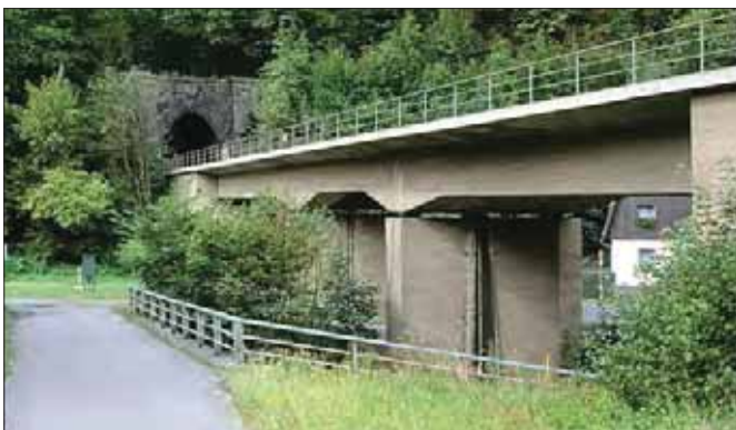
Die in den 1930er-Jahren gebaute Müglitztalbahn besitzt typische Brücken aus der damaligen Zeit mit charakteristisch geformten Lagern.
