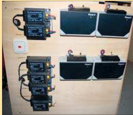
Übersichtliche Anordnung der elektrischen/elektronischen Bauteile, hier (links) die Booster
