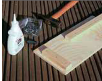
Die Ecken, in denen die Wangen aneinanderstoßen, werden ebenfalls mit Leisten versehen, die parallel zur Außenkante angebracht werden.
