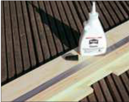
Die Rahmenwangen erhalten Leisten zur Auflage der Deckplatten. Sie werden genagelt und verklebt, geben zusätzliche Stabilität und gewähren Rechtwinkligkeit.
