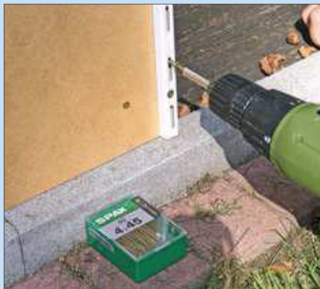
Die Regalträgerschienen zur Aufnahme der Multiplex-Brettchen des Beleuchtungssystems werden auf der Rückseite angeschraubt und befestigen so auch die Hintergrundkulisser am Rahmen.
