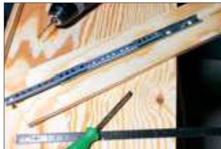
An die stirnseitigen Wangen der verschiebbaren Bühne werden vor dem Zusammenbau Schubladenführungen angebracht.
