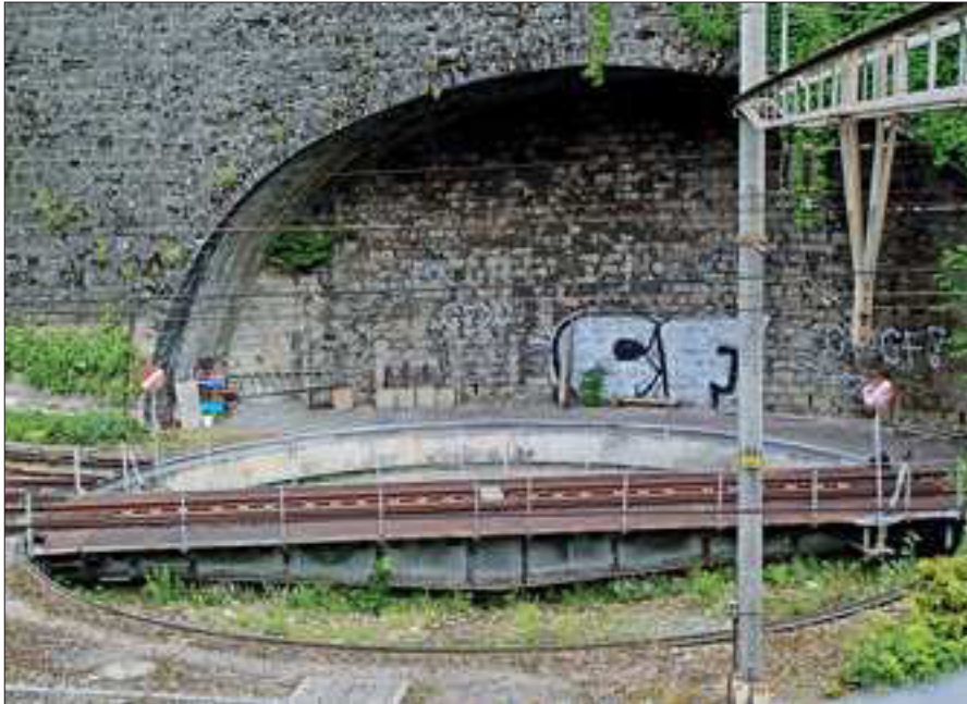
Die Drehscheibe weist vier Schienen auf. Sie dient zum Wenden sowohl der normalspurigen VCh-Dampflokomotive als auch von Schmalspurfahrzeugen der MVR, ehemals CEF.
