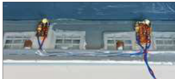
Oben links: Die LED-Deckenbeleuchtung des ersten Stockwerks im Betriebsgebäude Oben: Die beiden parallel geschalteten LEDs der Schuppenbeleuchtung Links und unten: Die LEDs im Einsatz
