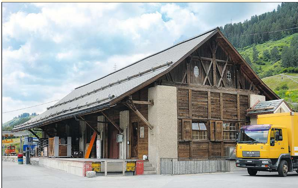
Der Güterschuppen von Scuol-Tarasp wird auch in der heutigen Zeit noch genutzt. Er ist obendrein ein architektonisches Juwel in dieser Gebirgsregion.
