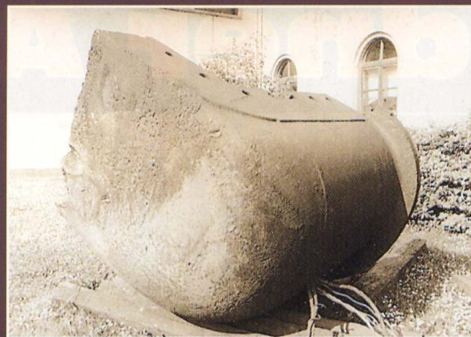
Aufwendig war die Bergung von festungstypischen Baugruppen auf dem ehemaligen Versuchsschießplatz Kammersdorf. Um diesen fast 35 000 kg schweren Panzerstand mit einem Bergepanzer herausziehen zu können, mußte er zunächst mittels Sprengung geteilt werden. Im Bild rechts die Hälfte.
