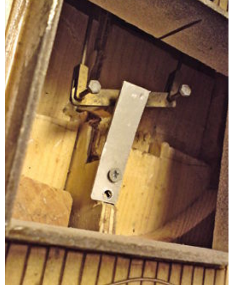
... und Ruderanlenkung wurden ausgebaut und erneuert
