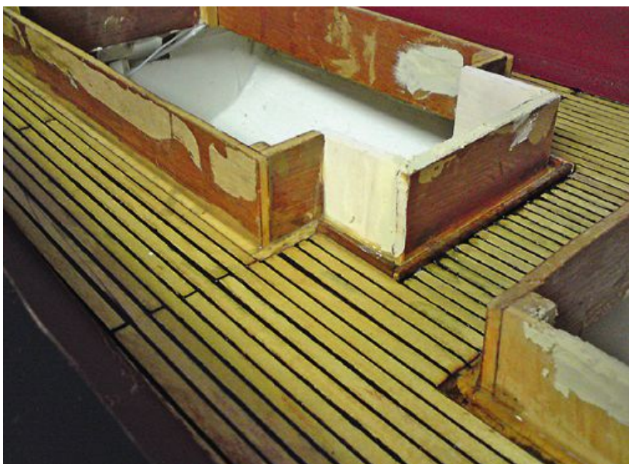
Die Süllränder der Ladeluken mussten erneuert werden
