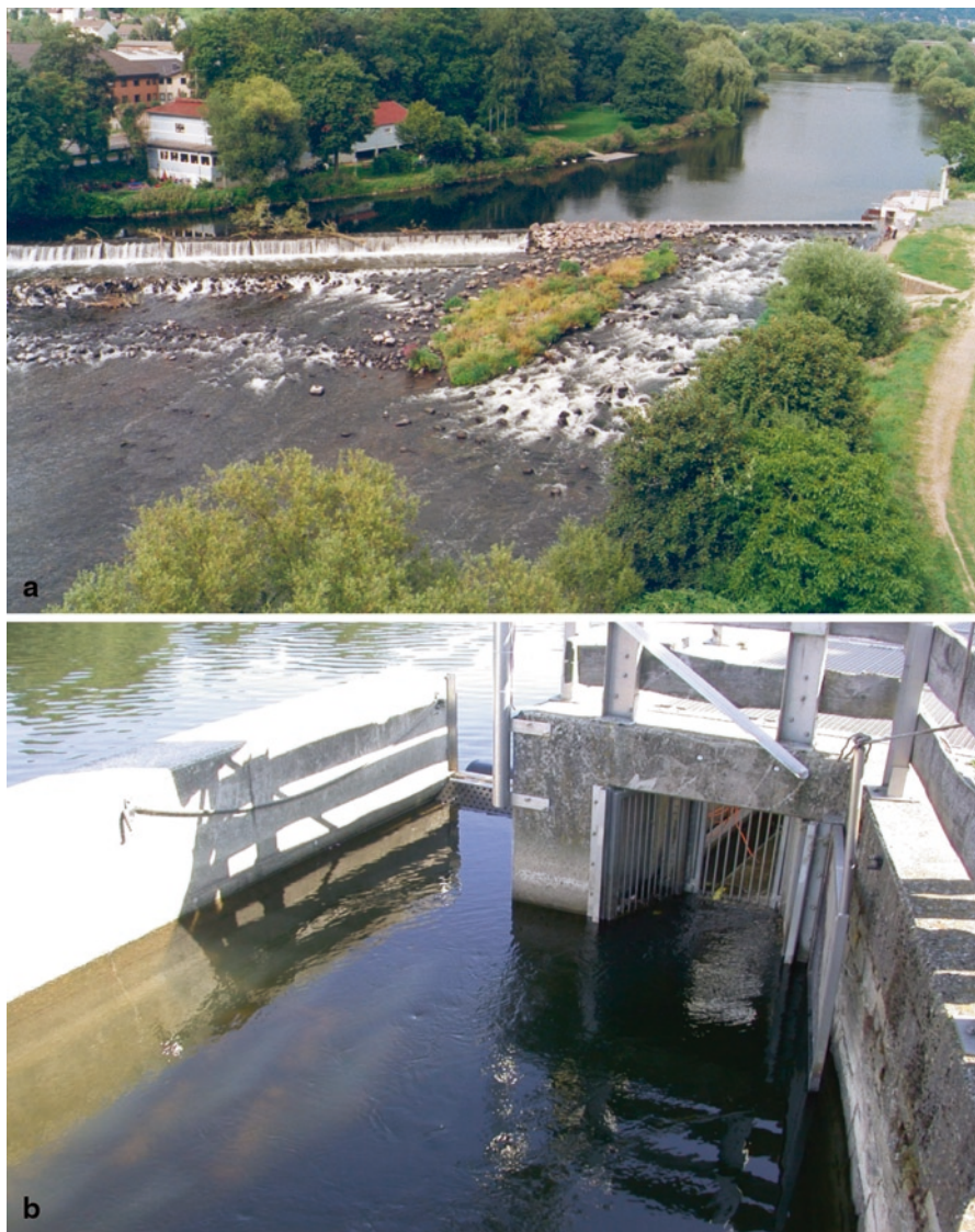
Abb. 4.67 Wehranlage mit Fischkontrollstation an der Sieg. a Gesamtübersicht der Wehranlage. Absturzwehr, Sohlenrampe und Fischkontrollstation (am linken Bildrand) – Blick gegen die Strömungsrichtung (Foto: E. Städtler). b Öffnung zur Fangeinrichtung. Der Fisch schwimmt gegen die Strömung an (Fischaufstieg) und wird durch die Lockströmung in Fangkammer geleitet – Blick gegen die Strömungsrichtung. (Foto: H. Patt)
