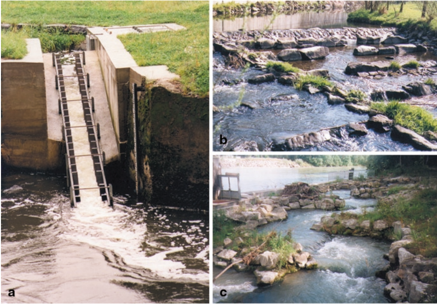
Abb. 4.65 Bauweisen von Fischpässe. a Denil-Fischpass (Foto: E. Städtler), b Rampe mit gesetzten Steinreihen (ältere Bauweise) im Mittelgebirge (Foto: H. Patt), c Umleitungsgerinne mit einzelnen Becken im Voralpenland. (Foto: H. Patt)
