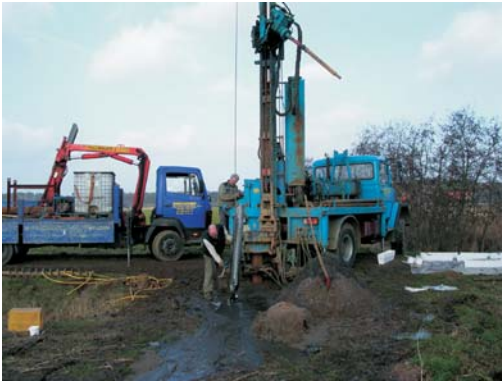
Abb.3-27 Rammkernbohrung mit Kiesbüchse
