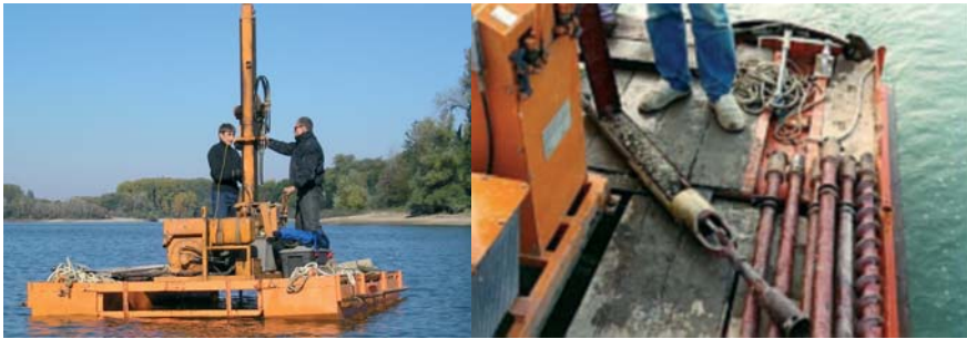
Abb. 3-31 Schwimmendes Drehbohrgerät für unverrohrte Probenahme mit Schappe
