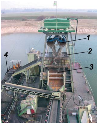
Abb. 5-14 Schwimmgreiferbagger mit integrierter Voraufbereitungsanlage, bestehend aus festem Rost über Kreisschwingsieb (1: Greifer, 2: Rost, 3: Sieb, 4: Schute)
