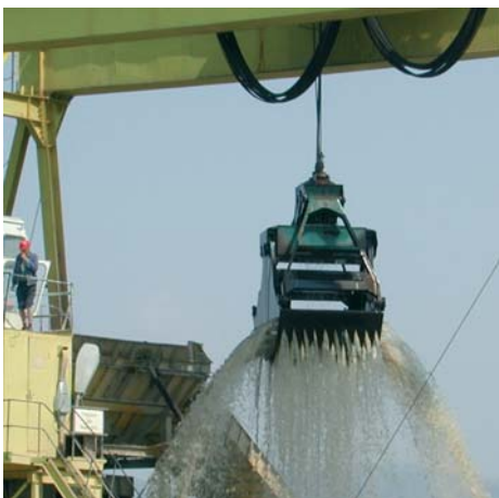
Abb. 5-31 Entwässerung des Greifer nach dem Heben
