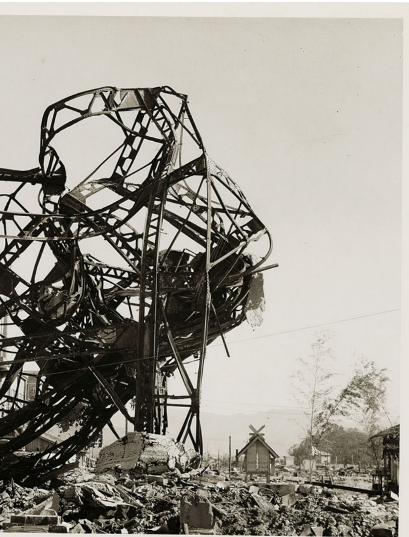
1 Deformierter Stahlträger des Odamasa-Bekleidungsgeschäfts, 20. November 1945
