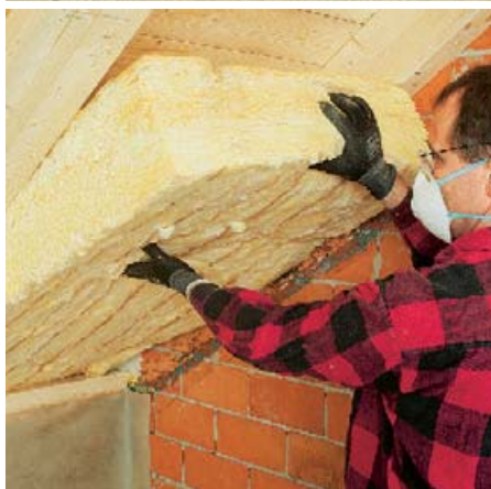
Pingelig: Exakter Zuschnitt und Einbau der Glaswolle sichert den Dämmerfolg.
