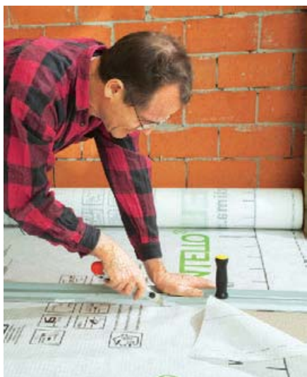
Dampfbremsfolien: Aufgedruckte Hilfslinien und Schablonen erleichtern den exakten Zuschnitt erheblich.
