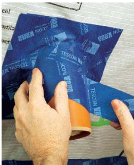
Klebeband: Mit einem flexiblen Band lässt sich auch eine Problemstelle wie diese Rohrdurchführung gut abdichten.
