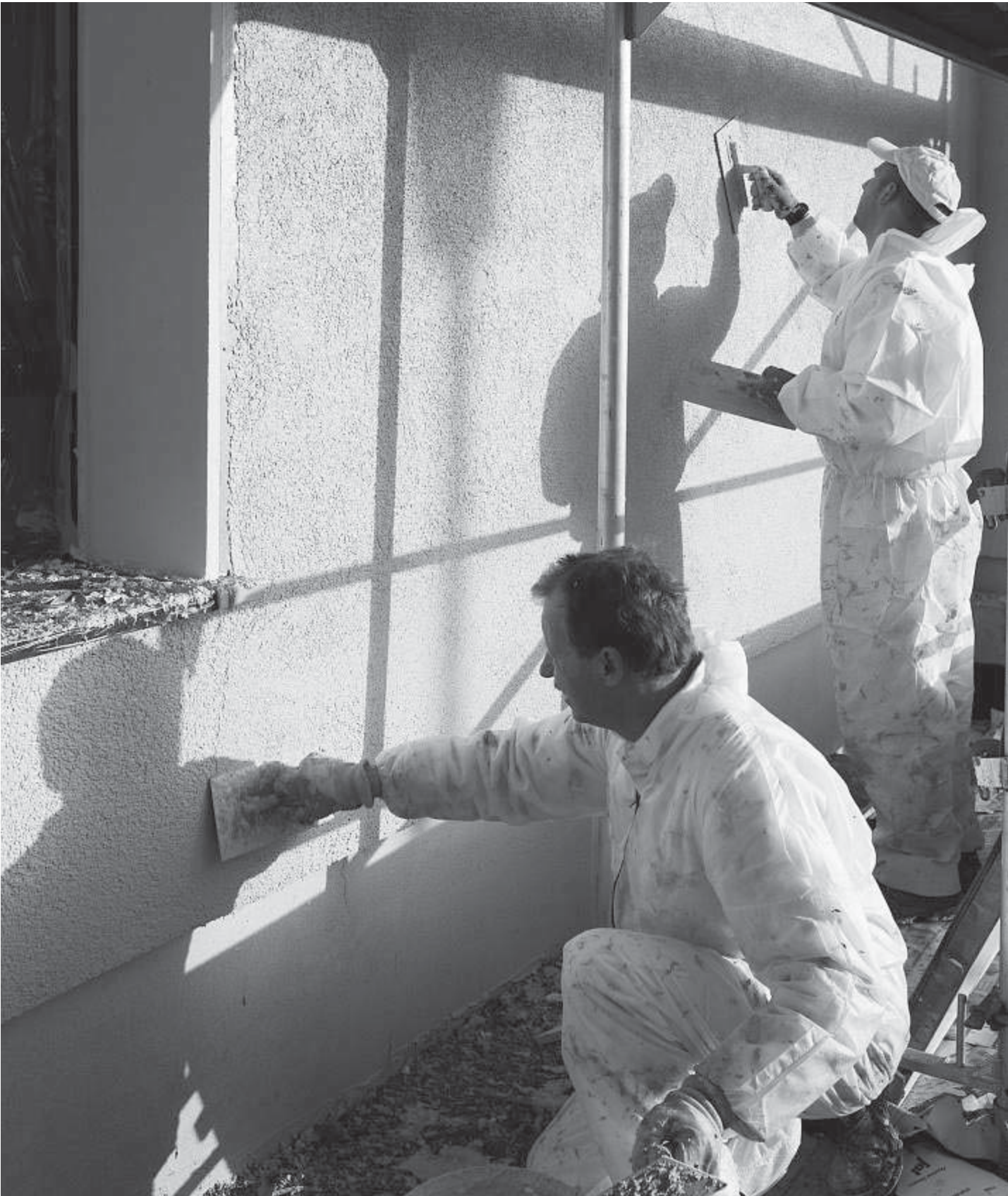
Dämmplatten vor die Wände, obendrauf der Putz: Das schafft Jobs, spart Energie und schützt das Klima. Wer bezahlt? Frank Schinski/Ostkreuz
