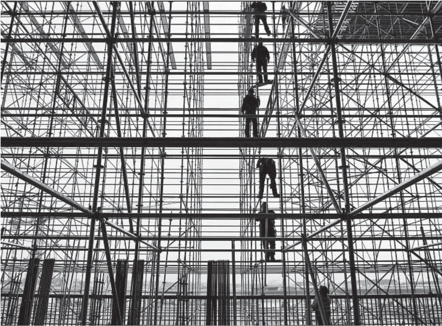
Sechs sind schon mal da: Bauarbeiter auf einem Gerüst am Pannen-Airport BER Foto: Klaus-Dietmar Gabbert/dapd
