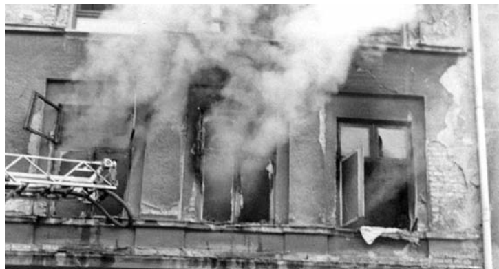
Wenn es draußen kalt ist, steigt der Energieverbrauch. Tip: Immer mal lüften. Dann wird es draußen wärmer, und man muss nicht so viel heizen! Vorsicht: Die Außentemperatur darf bis 2050 nur um zwei Grad klettern.
