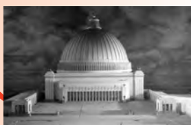
Hervorragender Wärmedämmwert: der Nachhaltigkeitsdom
