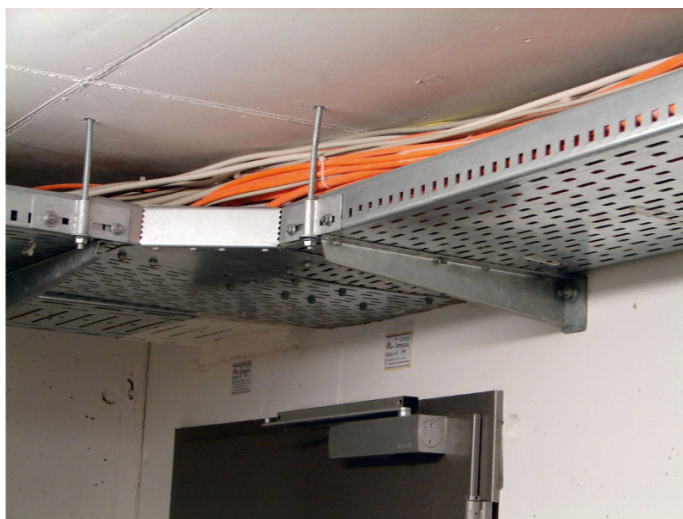
Bild 21.8: Überbelegung einer Kabeltrasse [45]
