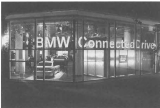
Abbildung 34: BMW Pavillon- Außenansicht (2003)
