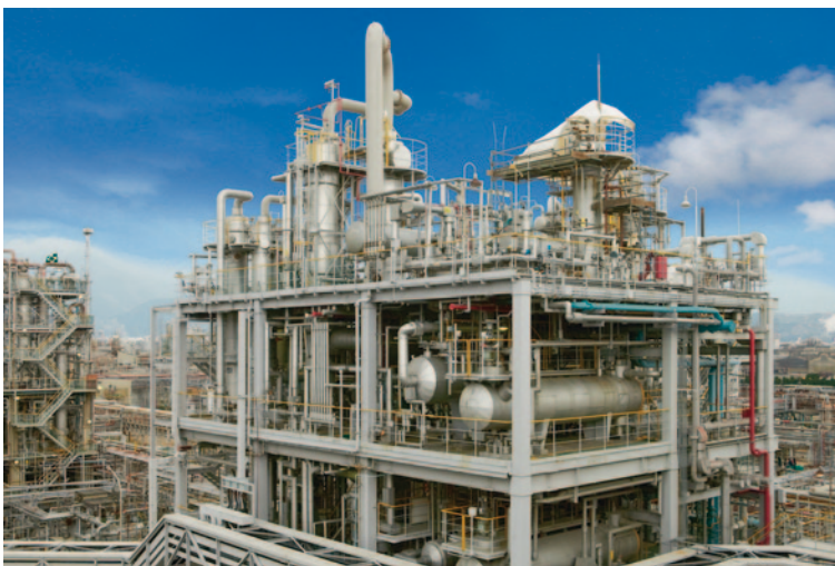
Abb. 7.8 Ausrüstungsgerüst einer Bayer Anlage. (Bild: Bayer AG)
