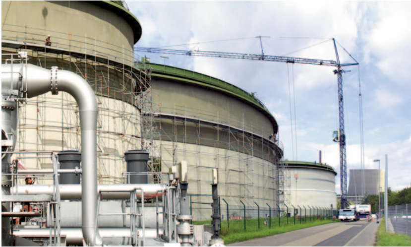
Abb. 4.3 Liebherr MK 88 im Einsatz. (Bild: Fa. Liebherr)
