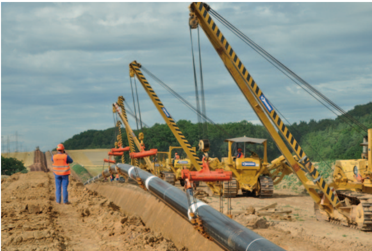
Abb. 2.7 Verlegung einer Erdgas-Pipeline. (Bild: GASCADE)
