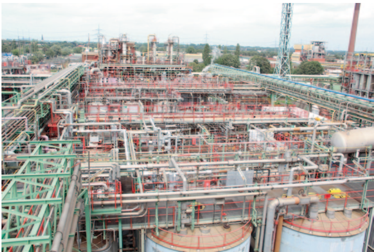
Abb. 3.14 Rohrbrücke im Chemiekomplex Bayer Uerdingen. (Bild: Bayer AG)
