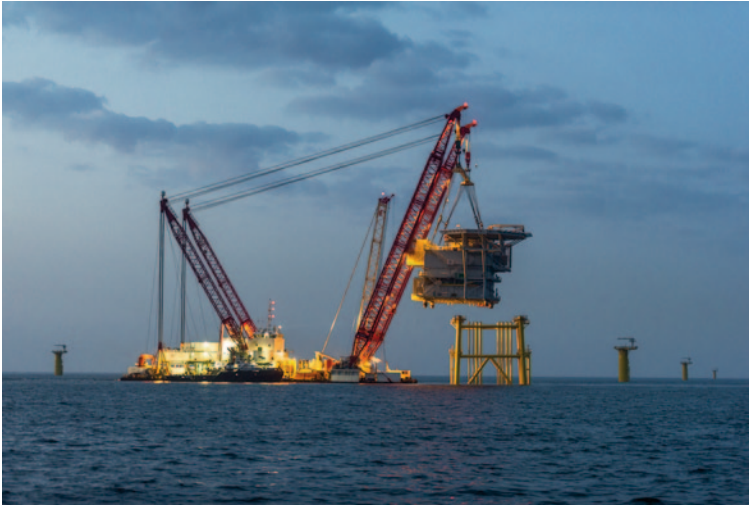
Abb. 4.11 Schwimmkran bei der Montage eines Umspannwerkes in der Nordsee. (Bild: E.ON SE)
