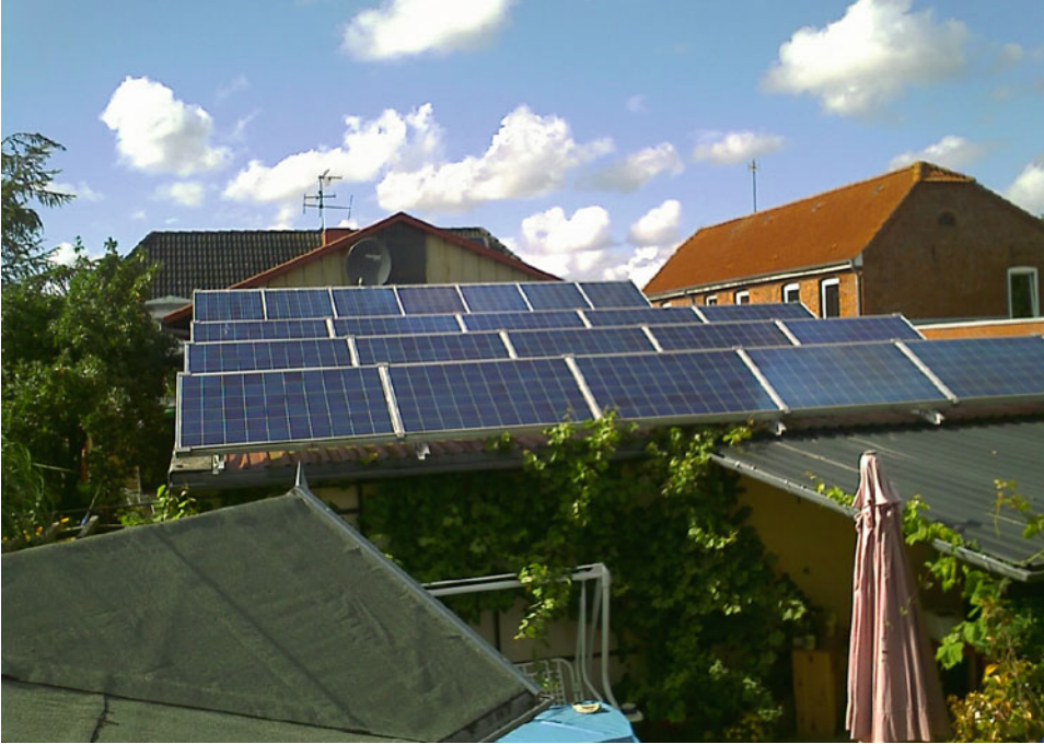
Abb. 2.19 Beispielanlage in Nordfriesland/Schleswig-Holstein
