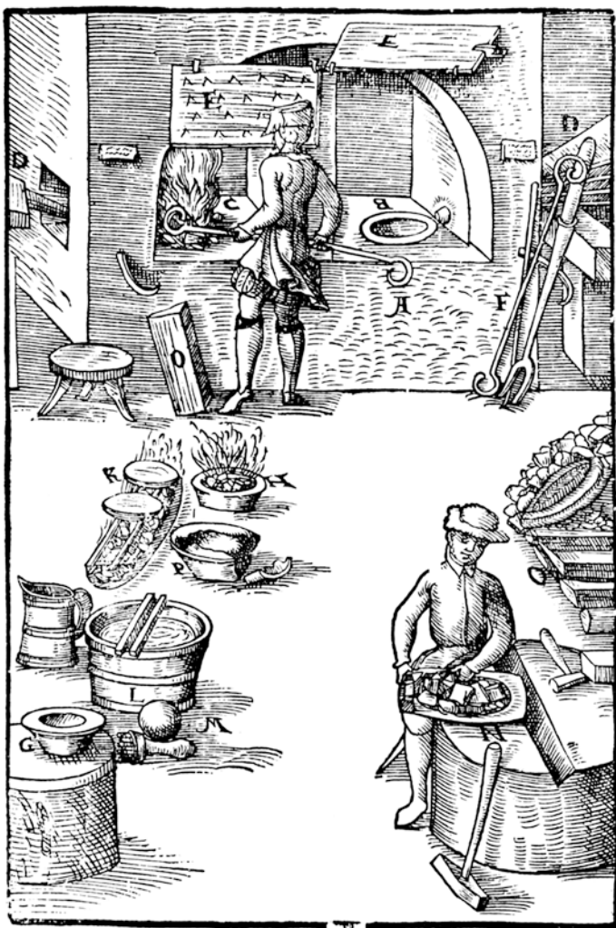
Abb. 3.2 Feinbrennen des Silbers in einem Berg- und Hüttenlaboratorium. (Gemeinfrei)
