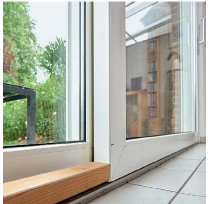
Türsicherung. Die Schiebetür geht nur auf, wenn der Holzbalken von innen entfernt wird.
