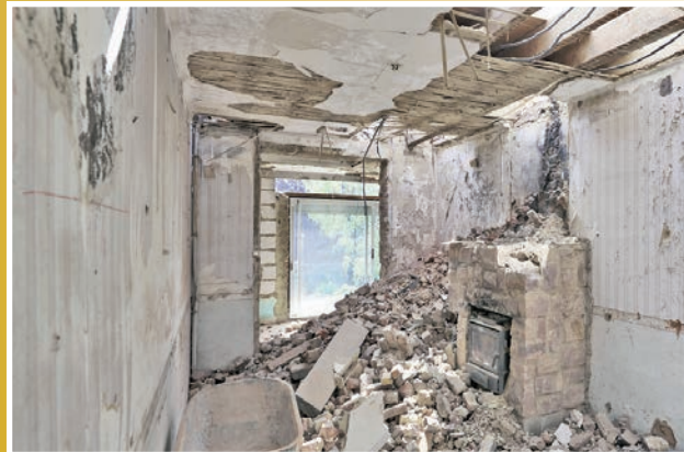
... und nach den Sanierungsarbeiten. – Ein Stück Heimat in der Fremde.
