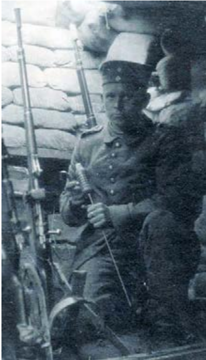
Unterstand mit Schießgestellen. Leere Leuchtpatronenhülsen aus Pappe schützen die Gewehrmündungen. Der Soldat hält den Hakenschlüssel für die Zünder.
