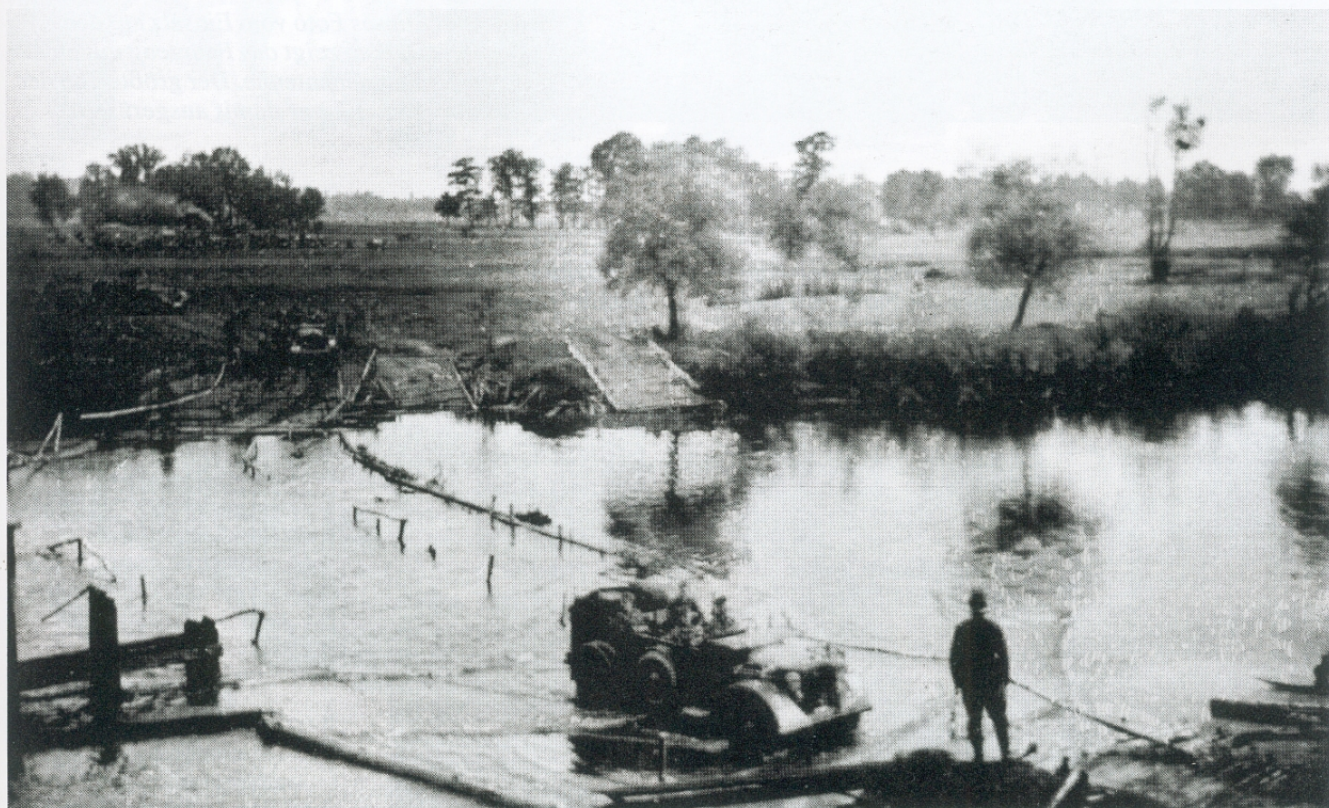
Eine Furt wird durchquert. Der mittlere geländegängige Einheits-Pkw hatte eine Wadfähigkeit bis 500 mm. Solche flachen Wasserläufe wie hier bereiteten dem Fahrzeug keine Probleme.
