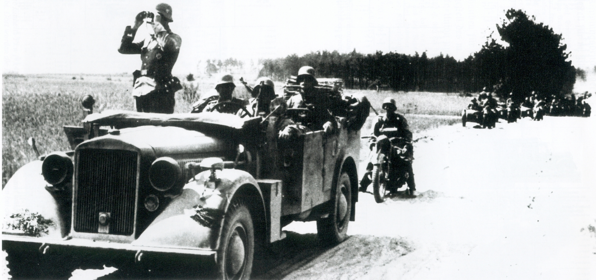
Kradschützen waren die beweglichsten motorisierten Verbände. Ihre Führungsfahrzeuge mussten sich der Beweglichkeit anpassen - der mittlere geländegängige Einheits-Pkw (4x4) erfüllte diese Voraussetzung.
