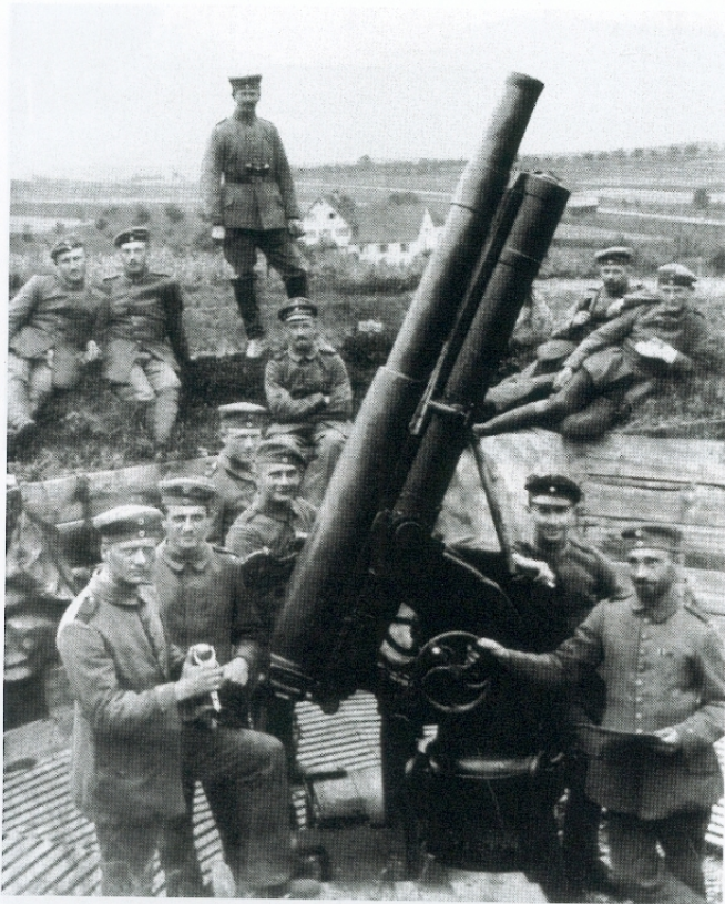
Die 7,62-cm-Fliegerabwehrkanone L/30 in Feuerstellung. Bei diesem Geschütztyp handelte es sich um einen deutschen Umbau aus dem Jahr 1915, der auf Grundlage zahlreich erbeuteter dreizölliger russischer Feldkanonen erfolgte. Mit der 6,85 kg schweren Granate ließ sich eine Schußhöhe von 5600 m erreichen.
