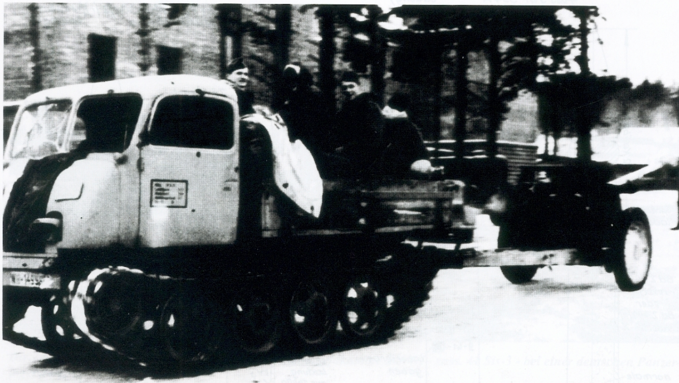
Raupenschlepper Ost (R.S.O.) mit angehängter 7,62-cm-Panzerjägerkanone 36. Mit diesem Zugmittel trat das leistungsfähige Panzerabwehrgeschütz in einzelnen schweren Zügen der Panzerjägerabteilungen von Infanteriedivisionen in Erscheinung.
