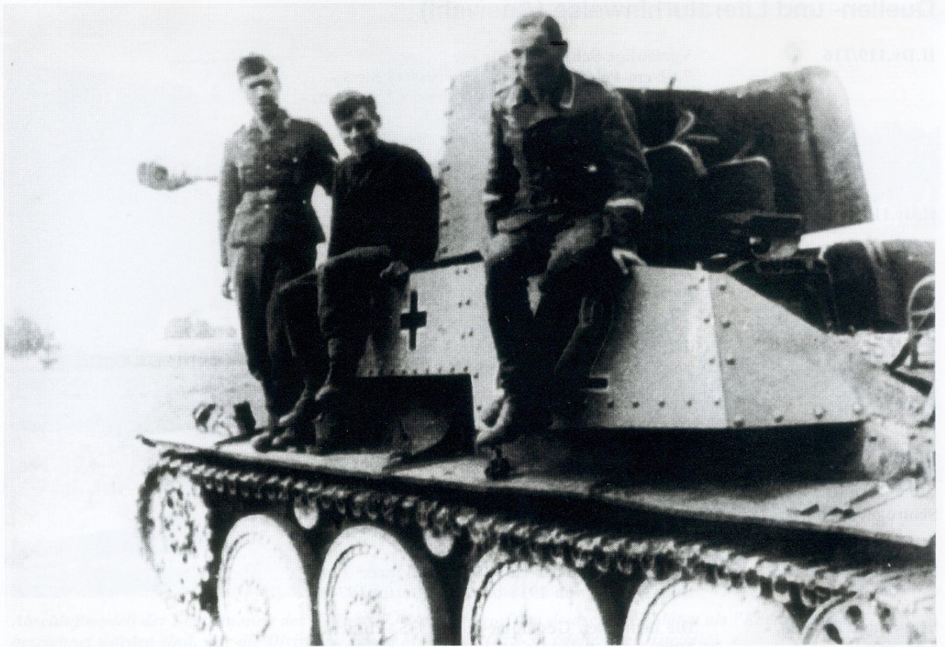
Auch bei diesem Panzerjägerfahrzeug zeigt der Aufbau und die Geschützlafettierung behelfsmäßigen Charakter. Das Schutzschild bestand aus 11 mm starken Panzerplatten.
