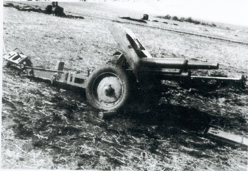
Als weiteres Geschütz mit einem Kaliber von 7,62-cm trat die Regimentskanone 27 in Erscheinung. Im Bild die Ausführung mit hartgummibereiften Holzspeichenrädern. Auch dieser Geschütztyp wurde von deutscher Seite in großer Zahl erbeutet und weiterverwendet.
