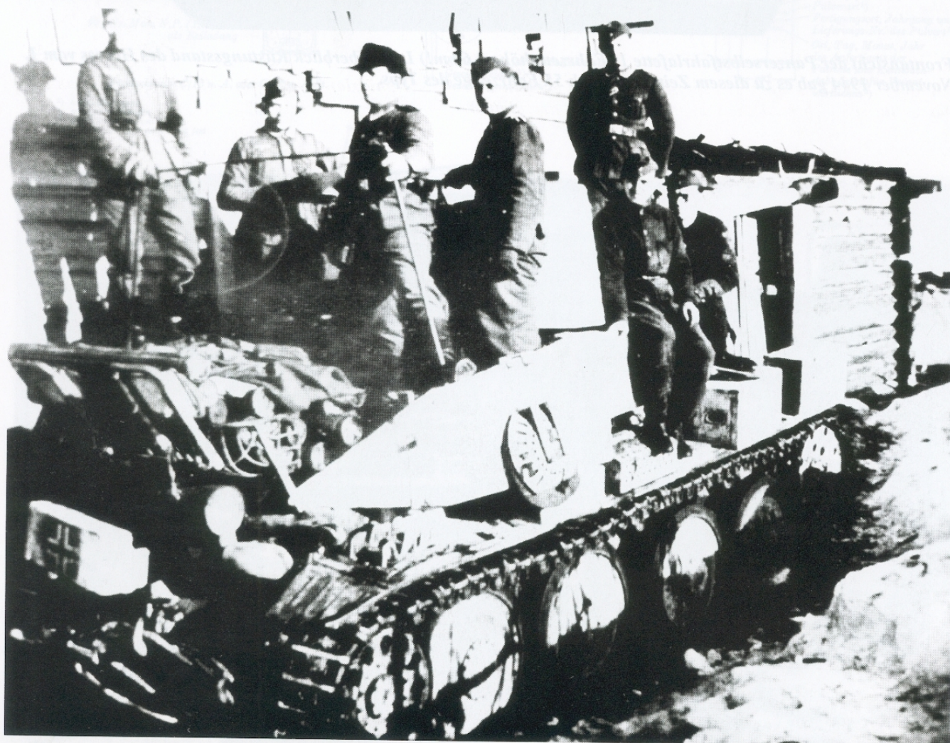
Der Panzerjäger 38 (t) für 7,62-cm-Panzerabwehrkanone 36 (Sd.Kfz. 139) wog 10,7 t. Das Geschütz ließ sich nach der Seite um 42 Grad und nach der Höhe zwischen -8 Grad/+13 Grad schwenken. 30 Granatpatronen wurden mitgeführt.
