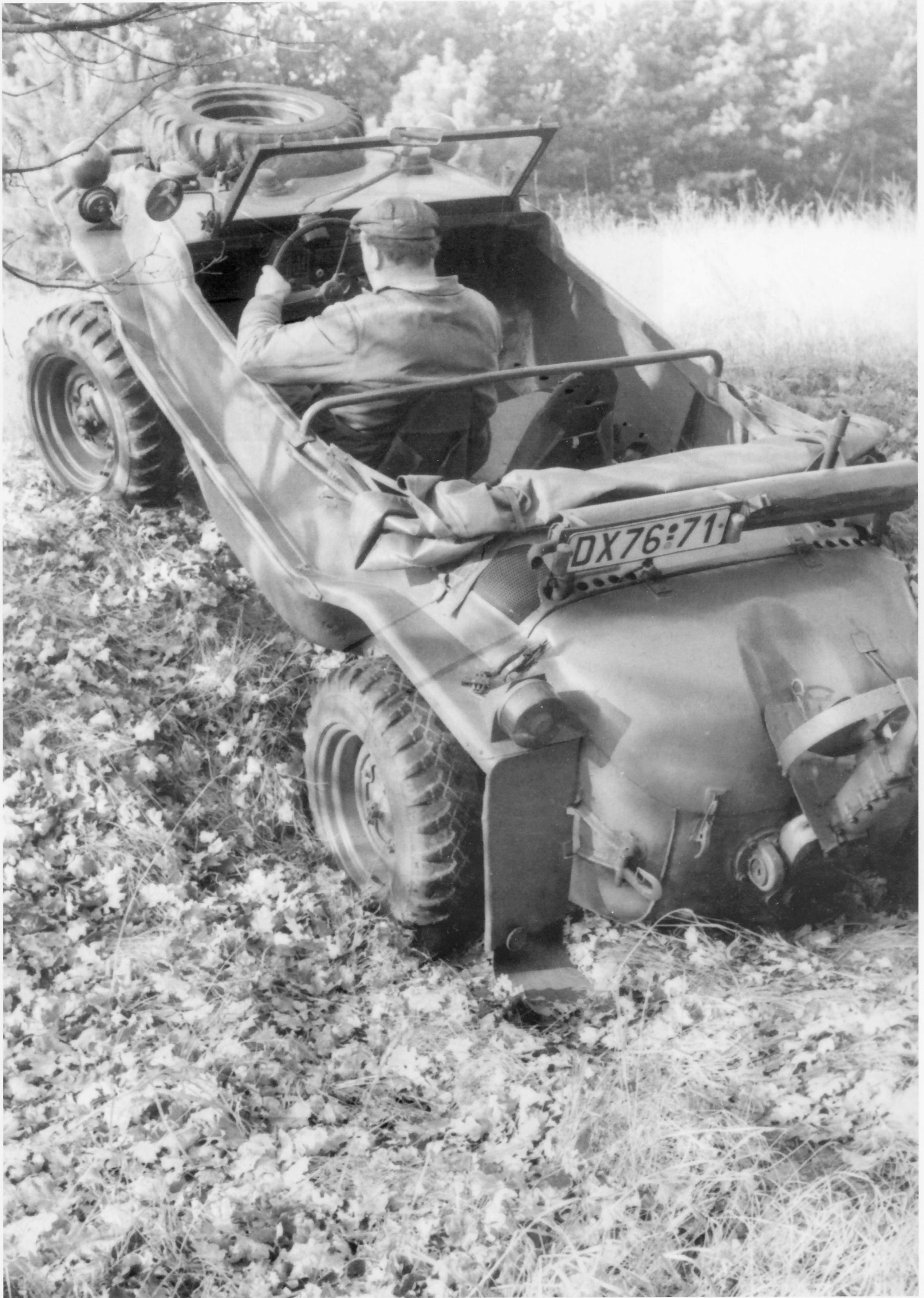
Unterwegs in Brandenburger Wäldern. Dieses Foto zeigt deutlich, dass solches Gelände nur mit hochgezogener Schiffschraube zu bewältigen ist.
