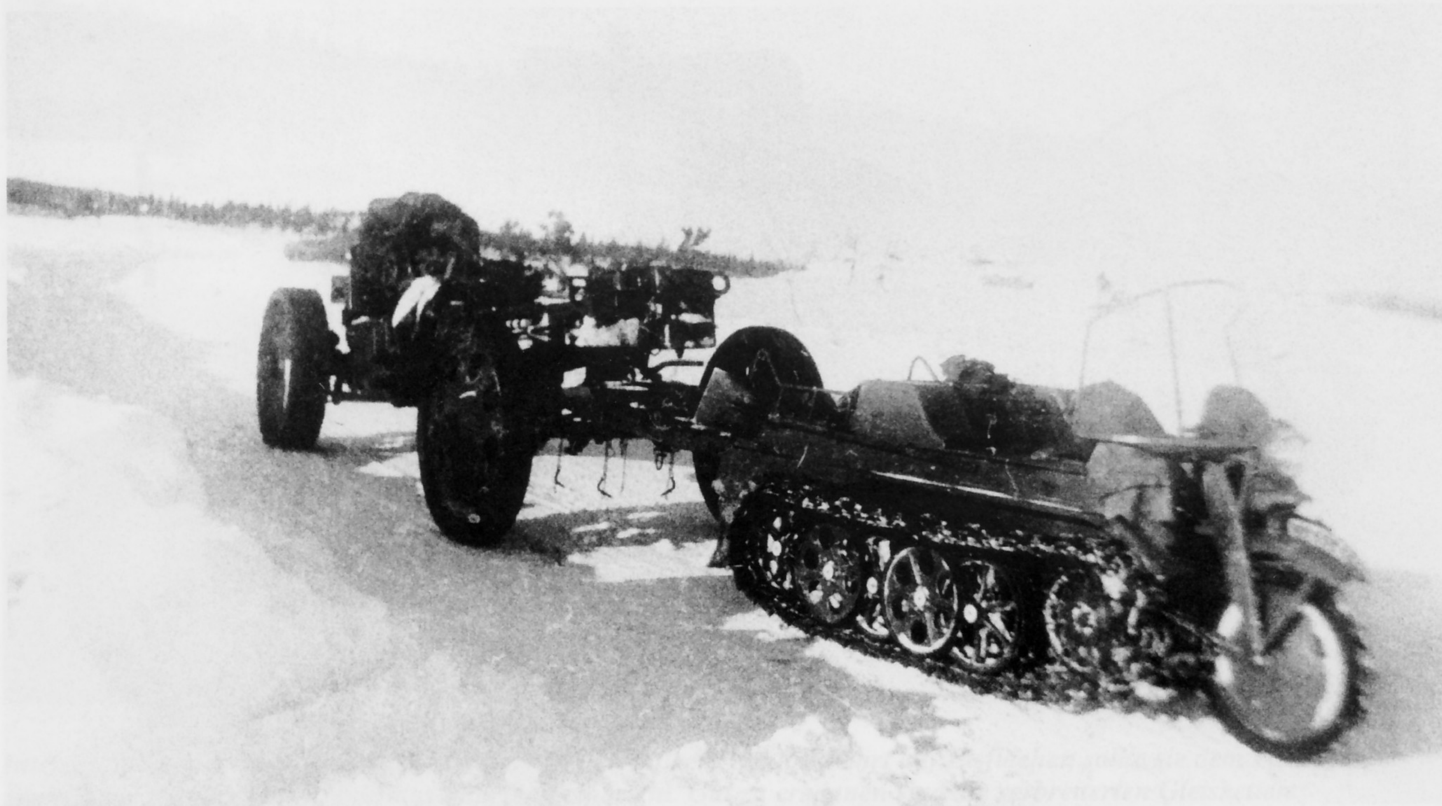
Zu weiteren Tests wurden Kleine Kettenkräder HK-101 (Sd.Kfz. 2) auch nach Norwegen gebracht. Hier bei einem Belastungsversuch mit angehängter 15-cm- schwerer Feldhaubitze.
