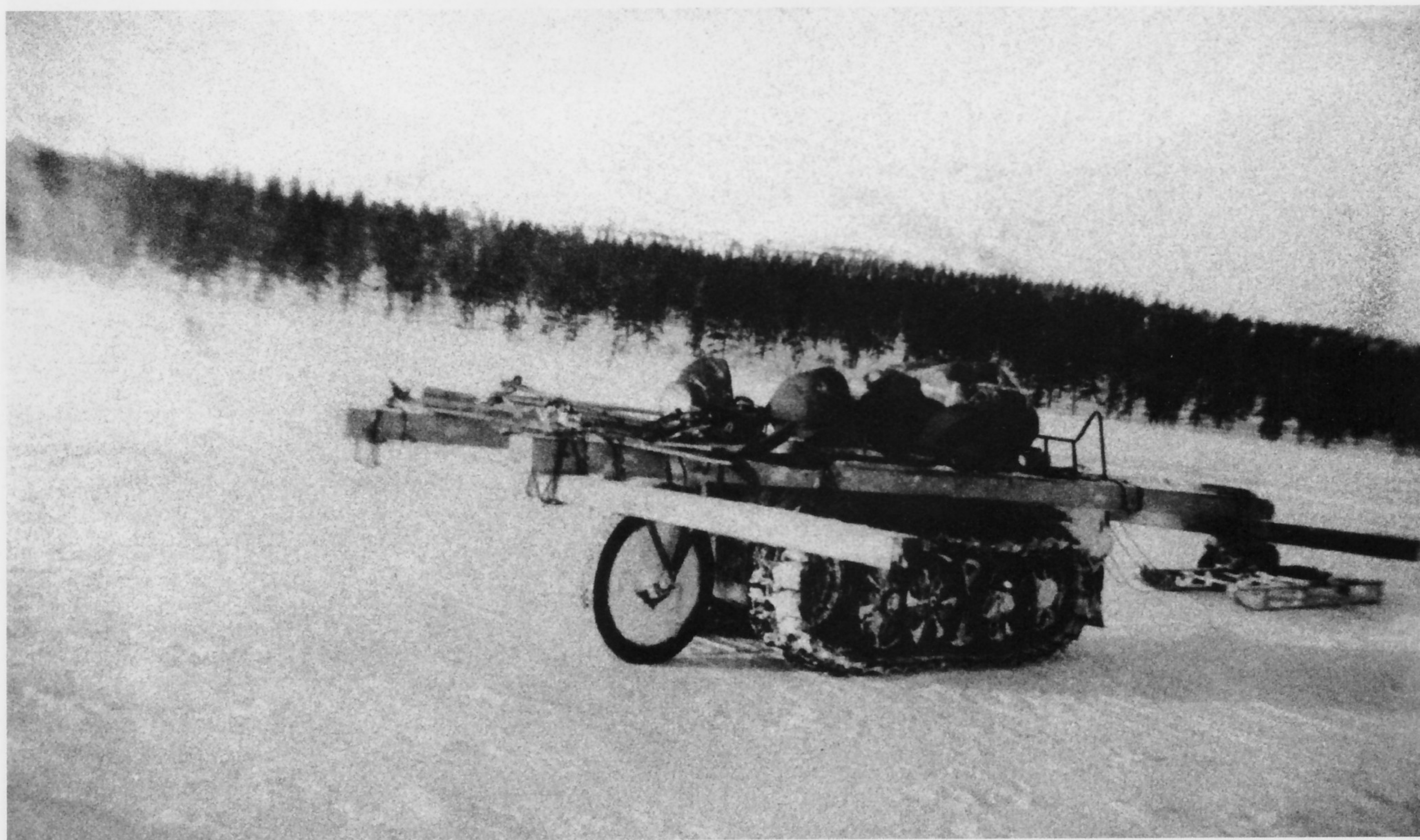
Interessant ist hier die provisorische Sicherung aus Balken. Bei der Fahrt auf Eisflächen sollte sie dem Fahrer Gelegenheit zur Rettung geben, falls das Fahrzeug einbricht. Gut zu erkennen sind die verbreiterten Gleisketten.
