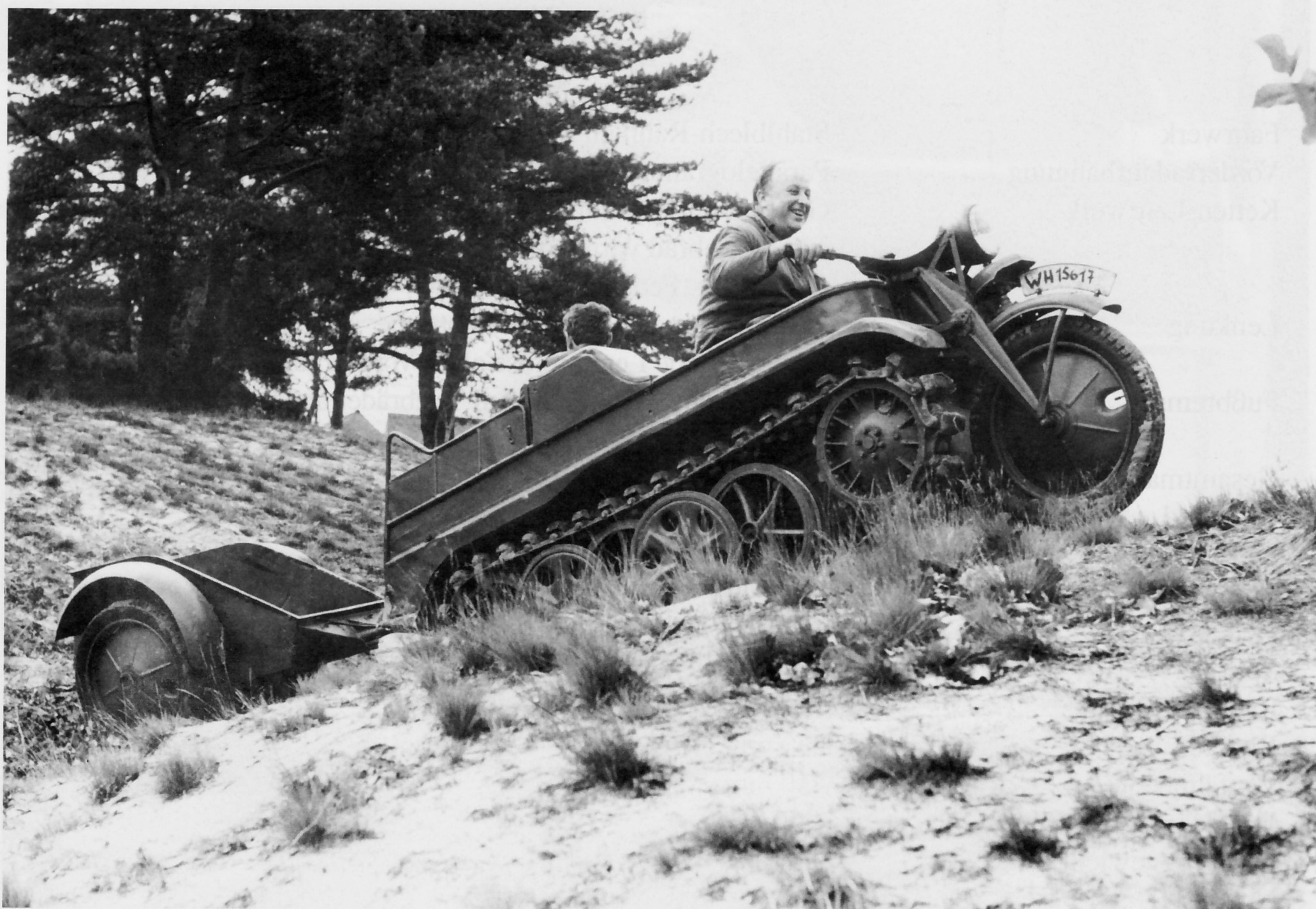
Dieses Foto, entstand im Mai 1984 in Brandenburg, zeigt das Kleine Kettenkrafttrad HK-101 (Sd.Kfz. 2) mit dem originalen Anhänger während einer Geländefahrt auf dem in dieser Region typischen Sandboden.
