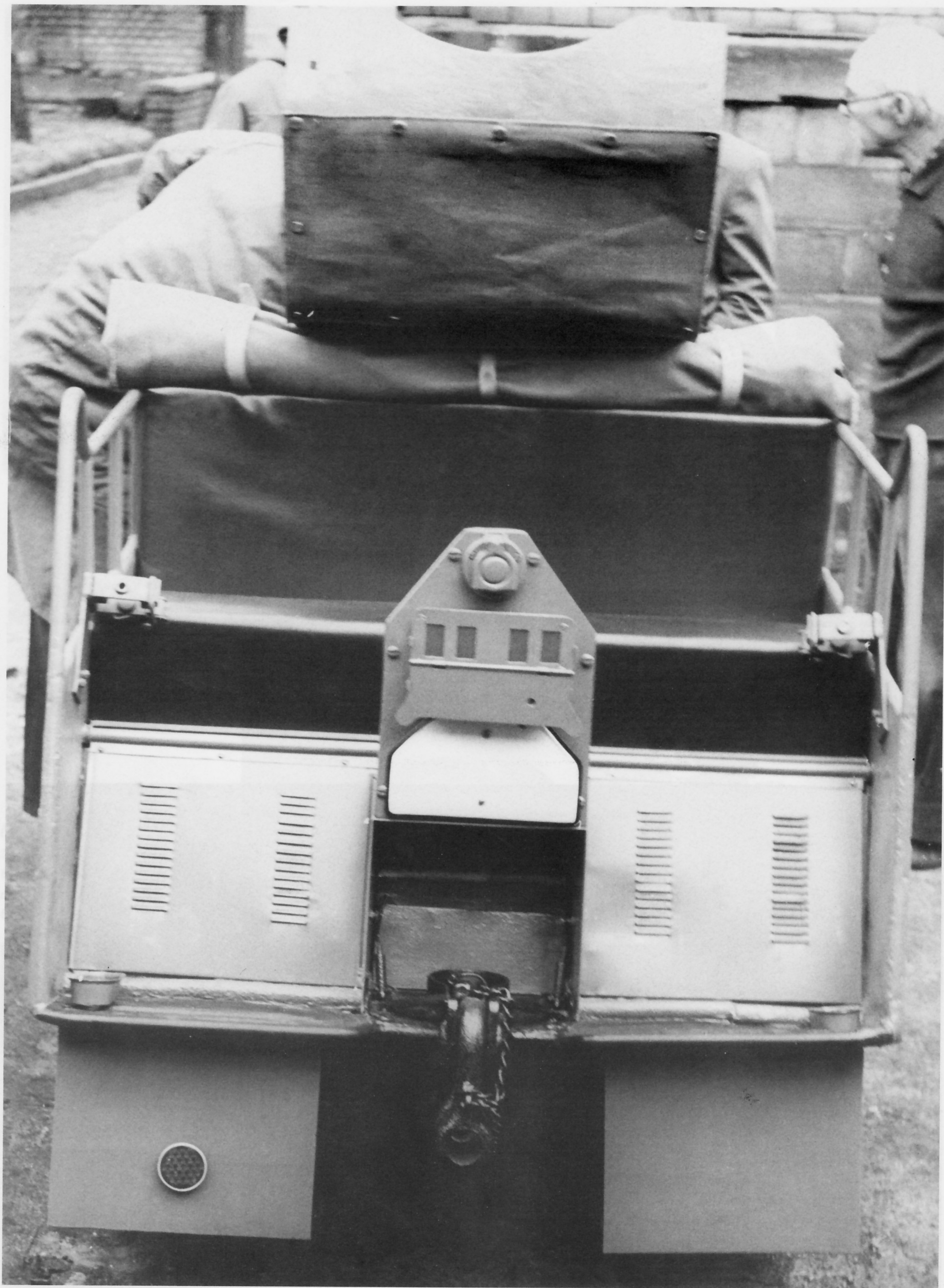
Heckansicht des Kleines Kettenkrafttrades HK-101 (Sd.Kfz. 2). Beachte hier die Abstandsrücklichter! Das Wirkungsprinzip beruht auf der Trägheit des menschlichen Auges, das erst ab bestimmten Entfernungen nebeneinander liegende Lichtquellen unterscheiden kann. Die Abstandsrücklichter erlauben eine exakte Einhaltung der Abstände beim Nachtmarsch. Auch gut zu erkennen sind die Karabinerschuhe und die Halteschellen dazu.
