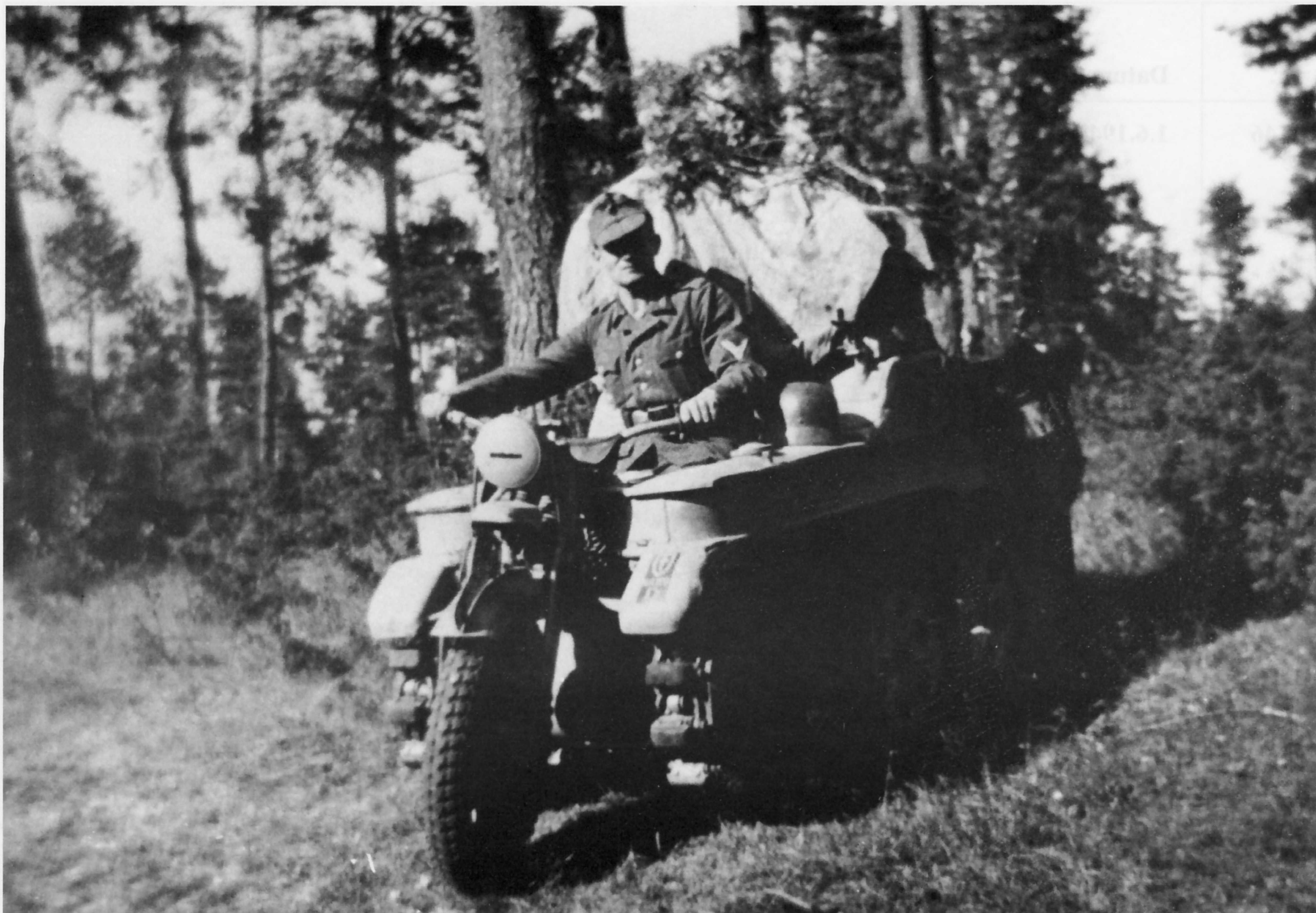
Beide Fotos auf dieser Seite entstanden 1943 an der Ostfront bei der 129. Infanteriedivision. Hier ist das Kleine Kettenkrafttrad HK-101 (Sd.Kfz. 2/1) als Kabelleger für Feldfernkabel zu sehen.
